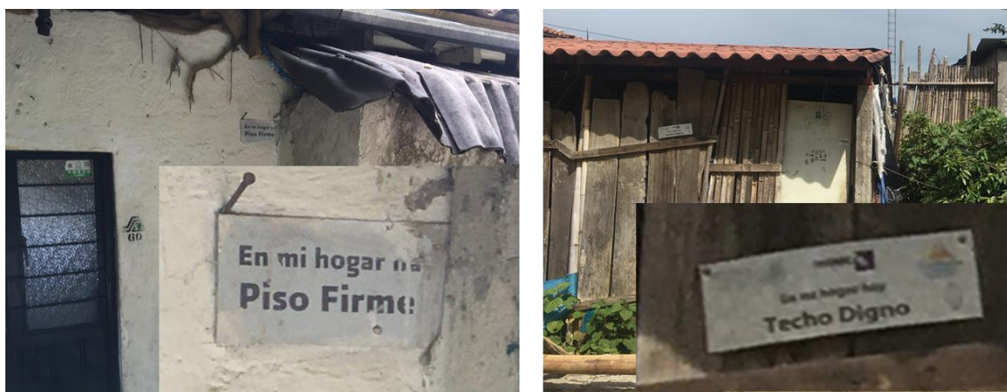
Figura 3.47. Hogares en Ciudad de Cuetzalan y San Miguel Tzinacapan con placas de programas de mejoramiento de vivienda.
