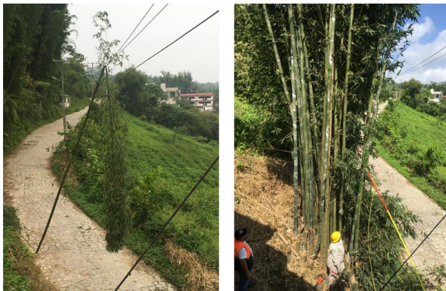
Figura 2.22. Remoción de un parche de guadua por interrupción de servicio eléctrico
