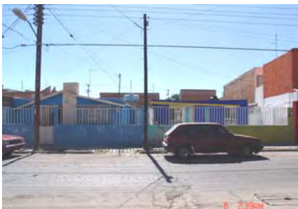
Foto3: Retornos, vista de las fachadas de 2 casas
