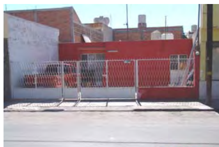
Foto4: Retornos, vista de la fachada de una vivienda.
