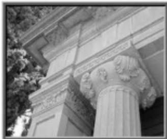
Foto 84.- *Detalle de la cantería en las columnas y capiteles de la cochera.*
