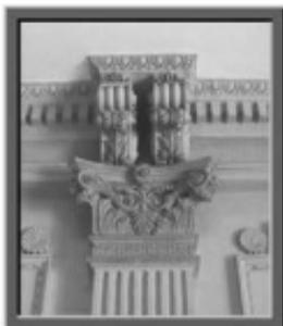
Foto 120. - Capitel y ménsulas pareadas de las pilastras del vestíbulo en la planta baja.
