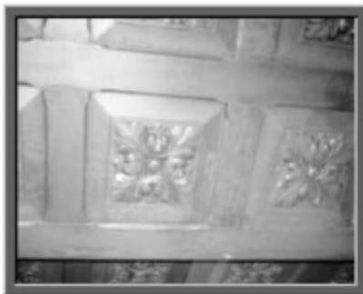
*Foto 111.- Detalle de la carpintería de las rampas de la escalera. Madera entablada de caoba.*
