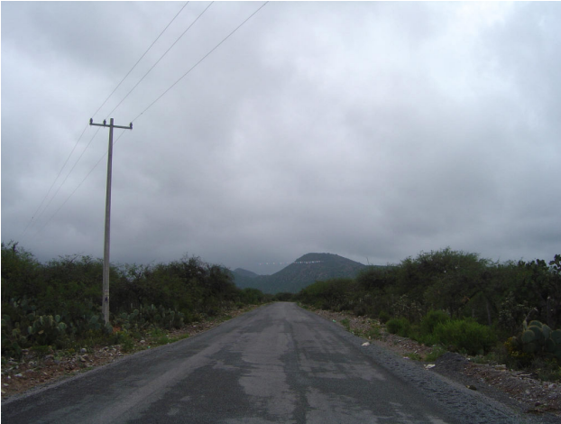
Estado actual del acceso a la cabecera municipal Villa de Zaragoza
