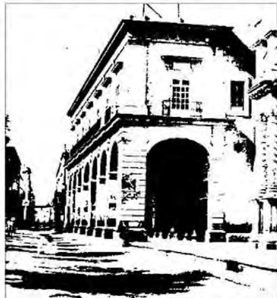
Fig. 2.33 Imagen del edificio del obispado en 1879. Antiguas Casas Reales y actual Palacio Municipal. (Imagen exposición, 'San Luis Potosí, reflejos de nuestra historia')
