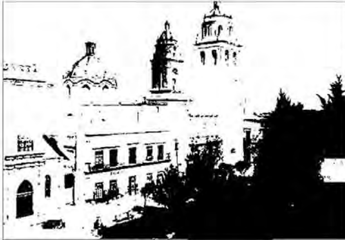
Fig. 3.40 Perfil poniente del conjunto franciscano a finales del siglo XIX. En esta imagen se observa la calle originalmente de tierra que se originó con la creación del jardín y que dejó sin atrio al templo de San Francisco y al protestante. (Imagen 'El San Luis que se fue')
