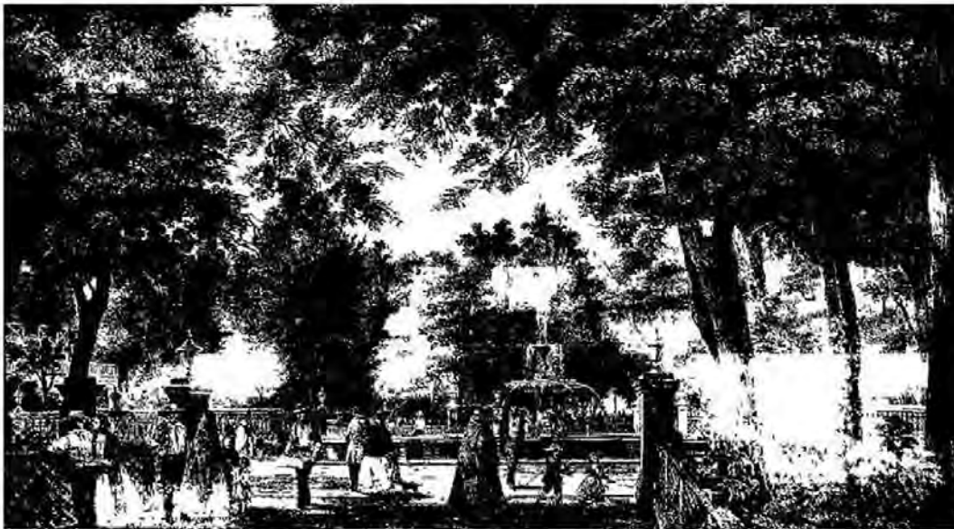
Fig. 2.6 Litografía de Casimiro Castro y Juan Campillo. Interior de la Alameda de la ciudad de México a mediados del siglo XIX.
