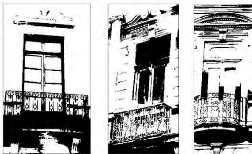
Fig. 4.33 Distintos tipos de balcones de herrería colada del edificio Ipiña. A la izquierda balcón de la fachada de la calle Obregón y al centro y derecha de la fachada de Carranza. Esta herrería es de principios del siglo XX. (Fotografías de la autora)
