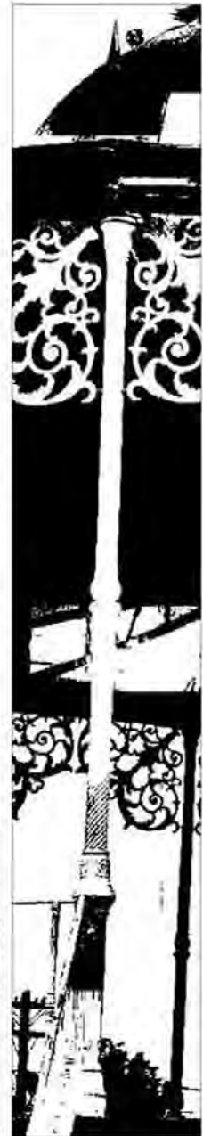
Fig. 4.16 Detalle de la estructura metálica del kiosco en forma de flor ó estrella la cual sostiene la cubierta de lámina. (Fotografía de la autora)
