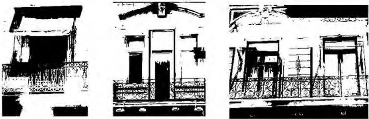
Fig. 4.31 Diferentes aspectos de los balcones de hierro colado y forjado que datan de principios del siglo XX, ubicados en el perfil norte de la Plaza de Armas. (Fotografías de la autora)
