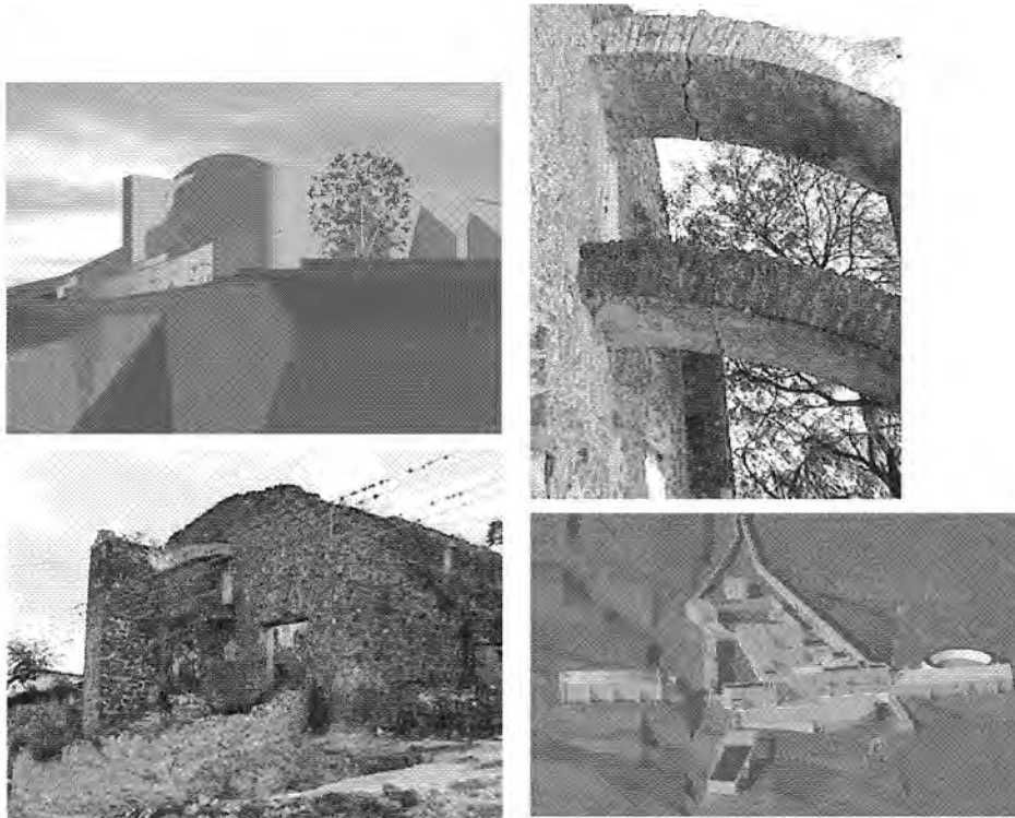
Figura 33 troje de la hacienda, posee un contrafuerte de doble arco que descansa al centro de una doble escalinata circular que desemboca en las dos naves que tenían como cubierta sendas bóvedas de cañón corrido. MADMP, CRJ 02
