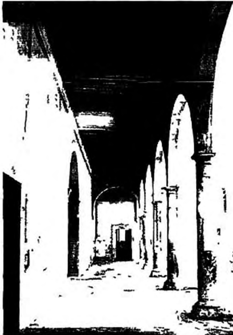
Columna como sistema de apoyo aislado en el corredor del patio central de la Casa Grande
