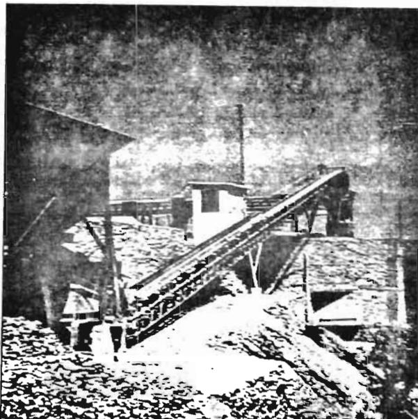
Foto no. 10.- Sistema moderno de alimentación de un horno en Estación Ventura. Consta de tolva almacenadora, transportador y tolva dosificadora.
