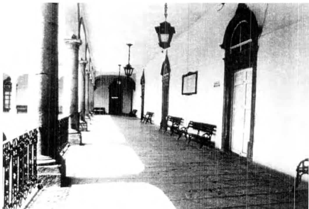
Corredor de la planta alta del Edificio Central. La segunda puerta de la derecha, de atrás para adelante, daba acceso a la Escuela y al Instituto de Física.
