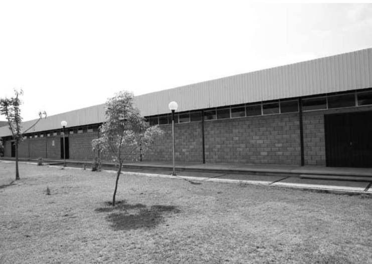
Instalaciones de la Unidad Académica Multidisciplinaria Zona Media, UASLP
