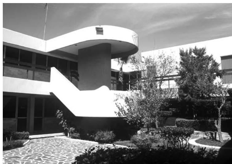
Instalaciones del Instituto de Investigación en Comunicación Óptica, UASLP
