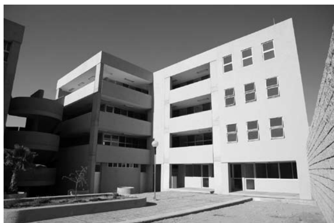
Aulas de la Facultad de Contaduría y Administración
