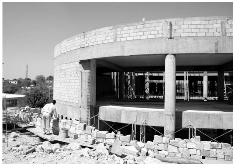
Biblioteca de la UAMZH, en construcción
