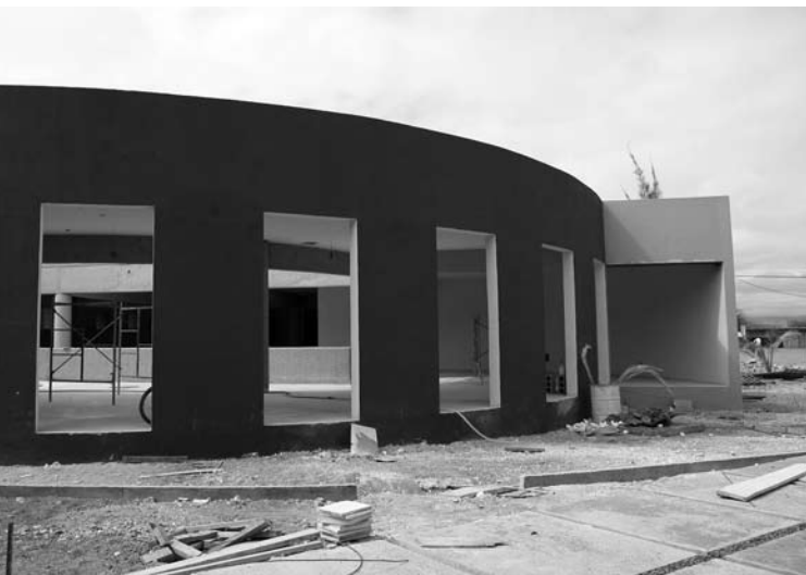
Biblioteca en construcción
