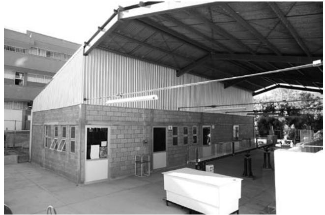
Laboratorio de Hidráulica de la Facultad de Ingeniería
