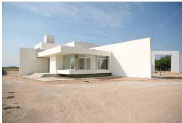
El Bioterio Regional de la UASLP construido en el periodo.
