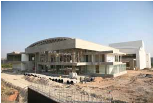
El nuevo auditorio con capacidad para mil 400 personas avanza en su construcción
