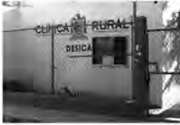
Clinica de DESICA instalada en la calle principal de la comunidad de E. Zapata.
