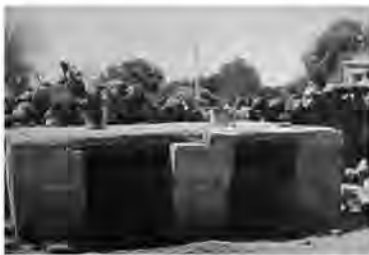
Construcción de la loza sobre los dos depósitos.
