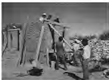
Construcción de caseta para letrina seca realizada por el Grupo DESICA.
