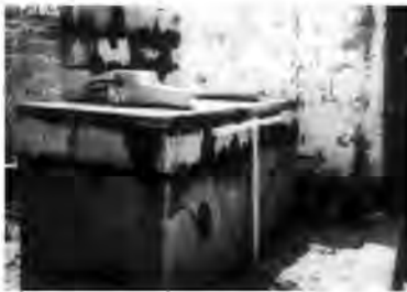
Se pegan las tazas separadoras con cemento-arena como tapas de los depósitos, haciendo coincidir el hoyo chico con el tubo.
