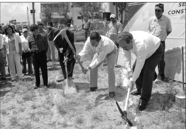
Se iniciaron los trabajos de remodelación de la Plaza Universitaria.
