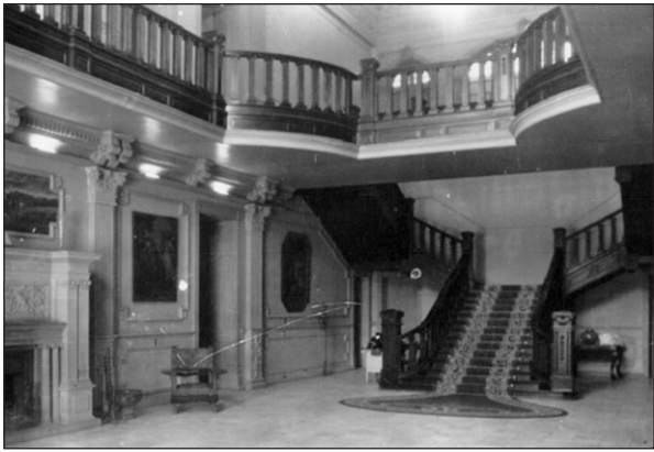
Vista interior de la quinta Vista Hermosa, propiedad de Gerardo Meade y Joaquina Sainz-Trápaga, s/f. Se aprecian algunas de las pinturas de la pinacoteca.
