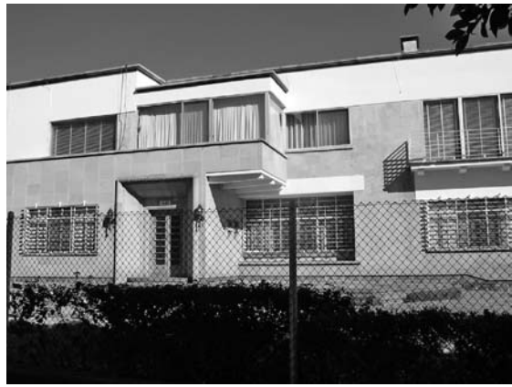
Casa Lozano Rodríguez, Cossío y Algara Arquitectos.
