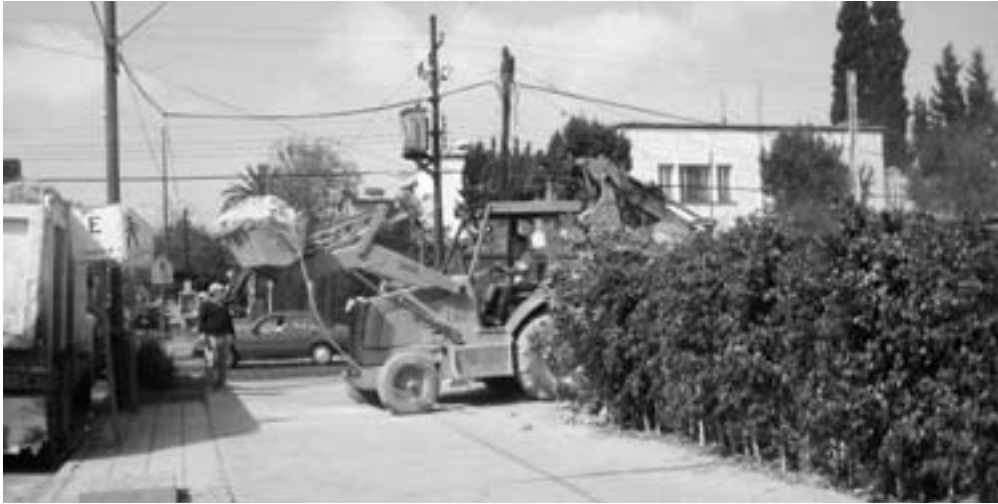
Foto 7. Acción cotidiana: casa en demolición para la banca invasiva.
