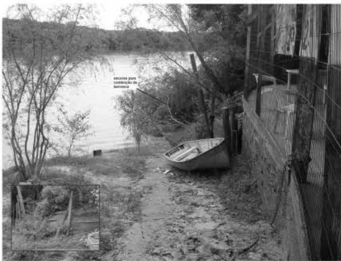
Figura 5. Construções sobre os terraços fluviais (barranca) do rio Jacuí, com escoras para contenção da barranca. No detalhe, as precárias escoras em madeira. FONTE: FRIEDRICH, 2007.
