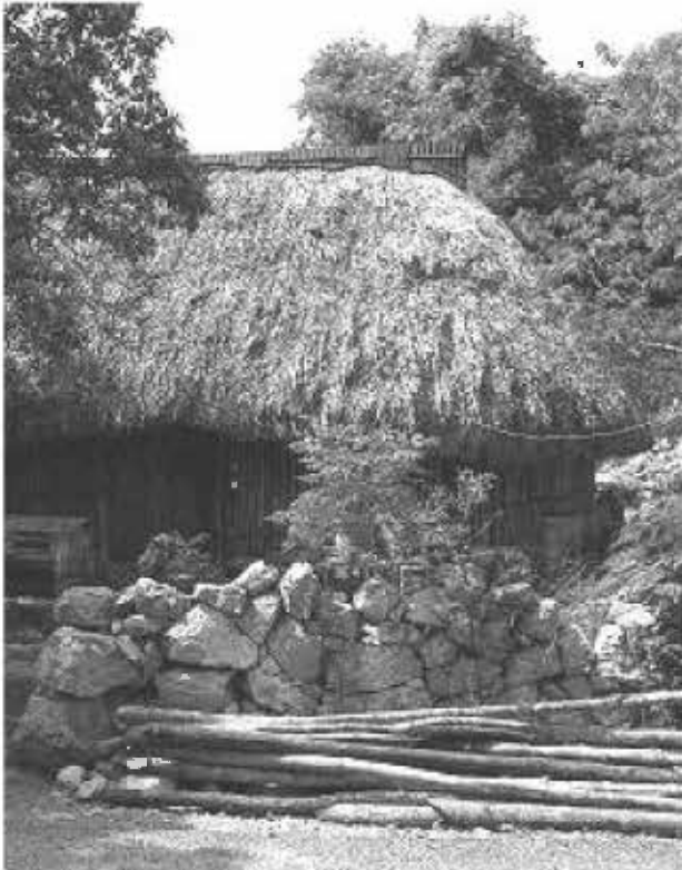
Figura 14. Tanchachín: Tipología de vivienda y materiales constructivos. Fuente: trabajo de campo.
