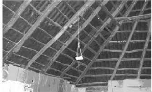
Figura 16. Tanchachín: Tipología de vivienda y materiales constructivos. Fuente: trabajo de campo.
