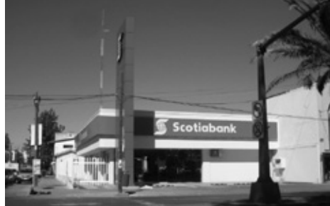
23. Casa Gómez, Av. Carranza y Capitán Caldera, con una mala intervención, (demolida), foto Jesús Villar. 24. Nuevo edificio del Scotiabank, Av. Carranza y Capitán Caldera, foto Jesús Villar.
