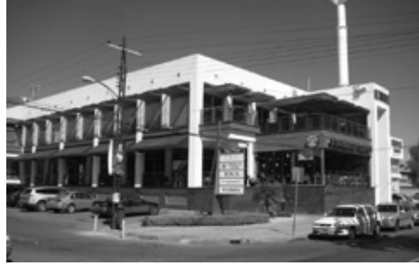
21. Casa López Servín, Av. Carranza y Humboldt, proyecto y construcción de Rodríguez y Quevedo, 1966 (demolida para construir la plaza comercial actual), foto Jesús Villar. 22. Plaza comercial, foto Jesús Villar.
