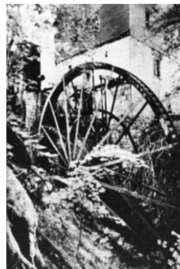
Imagen 6. Molino hidráulico de rueda vertical (aceñas) Grist Mill, Sepherdstown, West Virginia, Estados Unidos. (Tomado de Arqueología industrial, ilustración #62.) Fuente: NAVARRO Franco Víctor p.111
