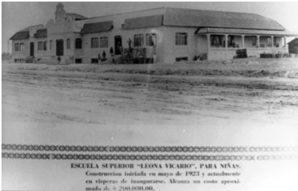
Fig. 8 Tarjeta Postal, parte frontal. Corresponde a la fotografía emblemática de la Escuela Superior Leona Vicario fundada en 1923, en la imagen se aprecian personas trabajando en su construcción. En la parte inferior se colocó ornamento tipográfico formando dos líneas, justo abajo se anexo la descripción de la foto en español. Imagen tomada del Acervo del CIC-Museo. Centro de Documentación y Archivos digitales. Universidad Autónoma de Baja California. Donación al CIC- Museo por parte del Sr. Roberto Arellano con registro número 03.
