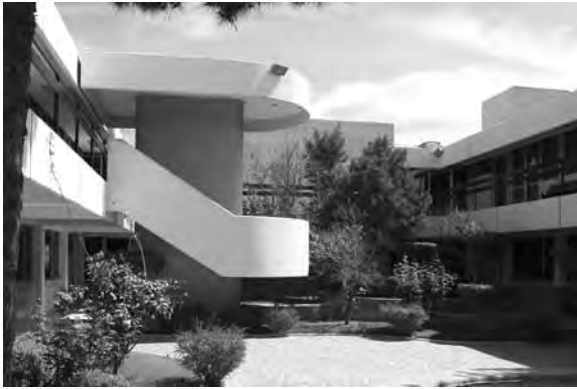
Edificio interior del IICO.
