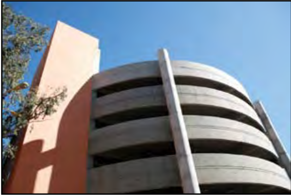
Estacionamiento en la Zona Universitaria Poniente.
