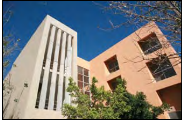
Edificio en la Facultad del Hábitat.
