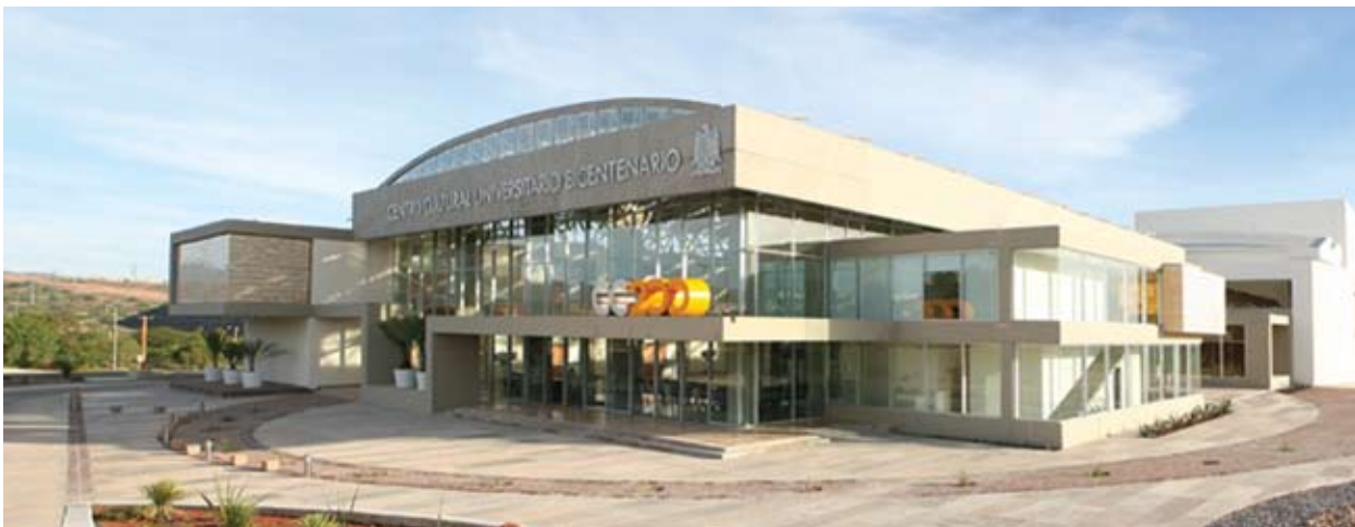
■ Panorámica del Centro Cultural Universitario Bicentenario de la UASLP.
