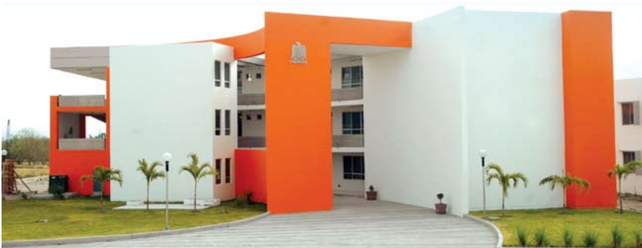
■ Instalaciones del Departamento Universitario de Inglés en el campus de Rioverde.
