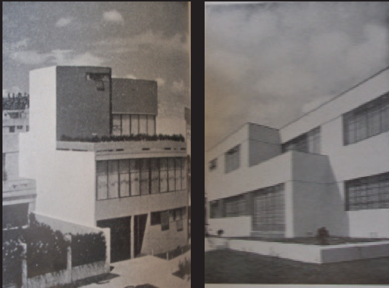
Revista Arquitectura México , No. 20, Dic. de 1946., Obras de Enrique Yáñez y Luis Martínez Negrete
