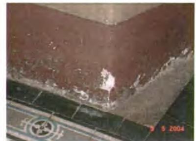
Fig. 59 Detalle piso y muro interior del Templo.
