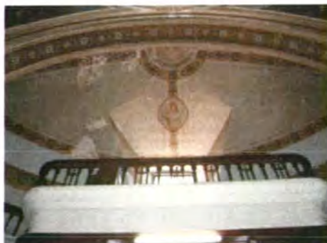
Fig. 74 Detalle cubierta coro. AVF
