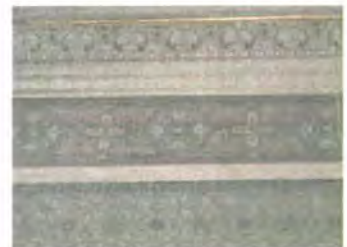
Fig. 92. Muro. Interior Santuario de Gpe. AVF
