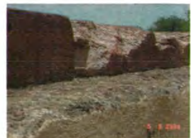
Fig. 61 Detalle muro. Atrio, AVF
