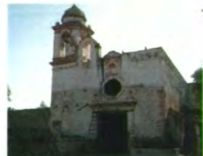
Fig. 4. Antigua capilla La Pila. AVF
