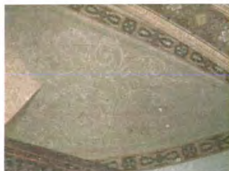
Fig. 73 Detalle cubierta coro. AVF
