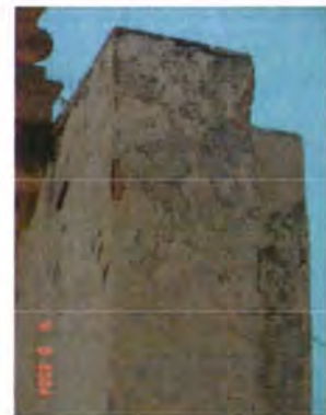
Fig. 60 Detalle muro. Atrio. AVF
