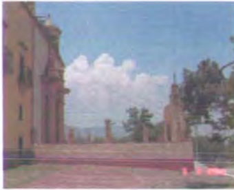
Fig.17 Fachada sur capilla La Ventilla AVF
