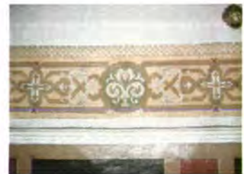
Fig. 91. Muro. Interior capilla, AVF
