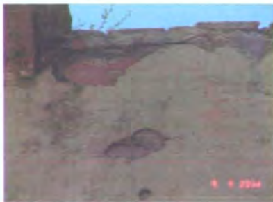
Fig.63 Detalle muro. Atrio. AVF
