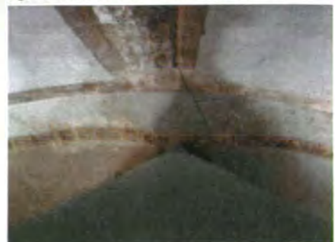
Fig. 72. Detalle de unión cubierta columna. AVF
