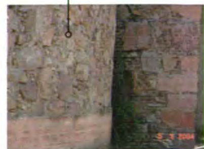
Fig. 66 Detalle en muro, AVF
