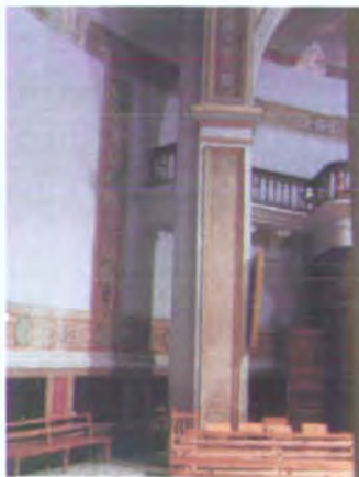
Fig. 69. Detalle de columna. AVF
