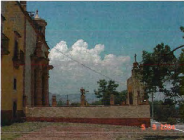
Fig. 29 Fachada lateral sur. AVF
