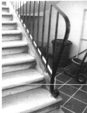
Detalle de pasamanos en escalera interior de edificio de departamentos Fotografía Diana Blanco
