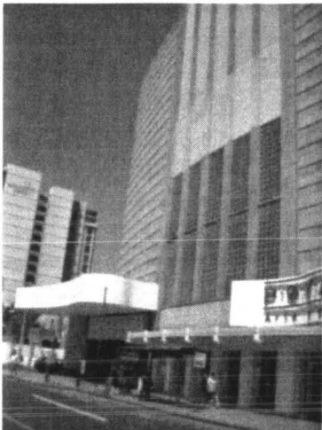
Fachada Cine Avenida Fotografía Diana Blanco
