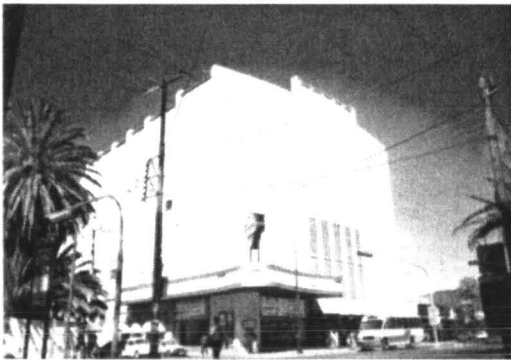
Fachada Cine Avenida Fotografía Diana Blanco
