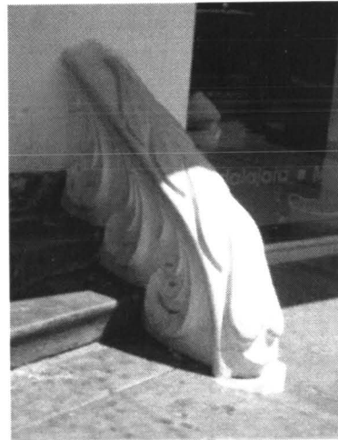
Detalle de la alfarda en escalinata de acceso sobre Av. V. Carranza Fotografía Diana Blanco
