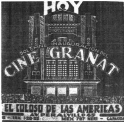
Impreso de inauguración del Cine Granat (1926) de los arquitectos Crombé y Guillermo Zárraga, podemos observar que para el Teatro Azteca Crombé acude nuevamente al empleo de las grandes columnas aparentes y al arco monumental en su fachada
