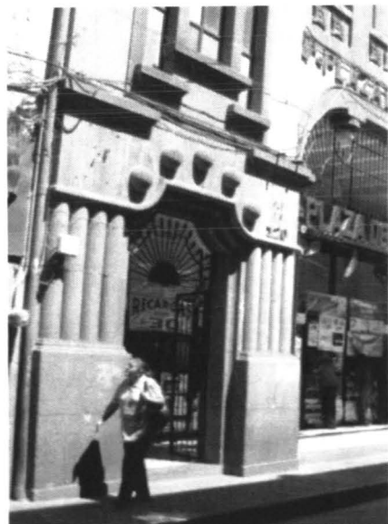
Detalle de una puerta lateral para acceder a balcón y galería Fotografía Diana Blanco
