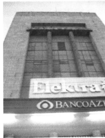
Fachada actual del Cine Hidalgo Fotografía Diana Blanco
