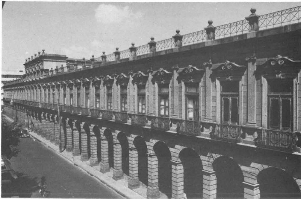
Estado actual de la fachada de la calle de Maltos (actual Av. Carranza). Fotografía Arq. Jesús Villar Rubio.
