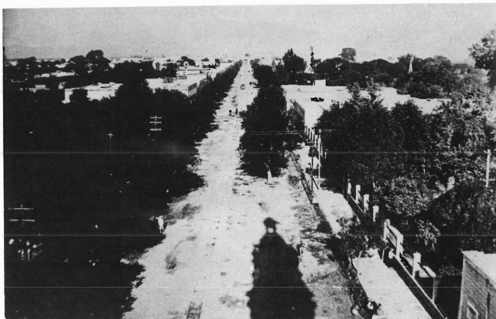
Fotografía. Antecedente, vista desde el Templo de Tequisquiapan (demolido), de la Av. del Centenario, en la que se puede observar el torreón del pabellón antes mencionado (marcado con una flecha). Archivo Histórico del Estado de San Luis Potosí.
