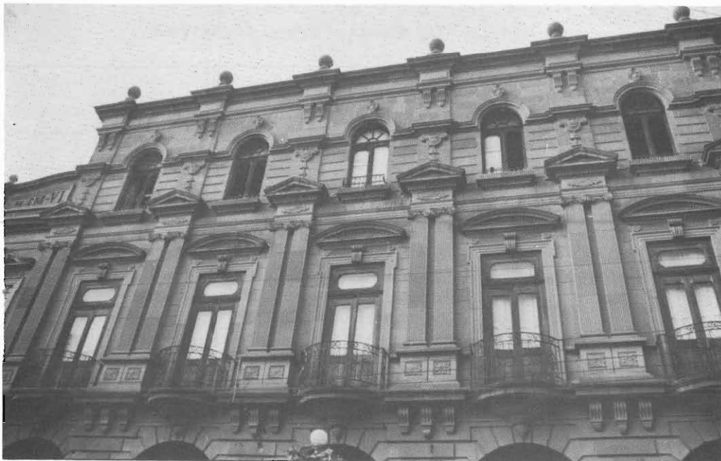
Detalle de la parte central del edificio en tres niveles, en donde se puede apreciar, la composición diferente al plano de la página anterior. Fotografía Arq. Jesús Villar Rubio.
