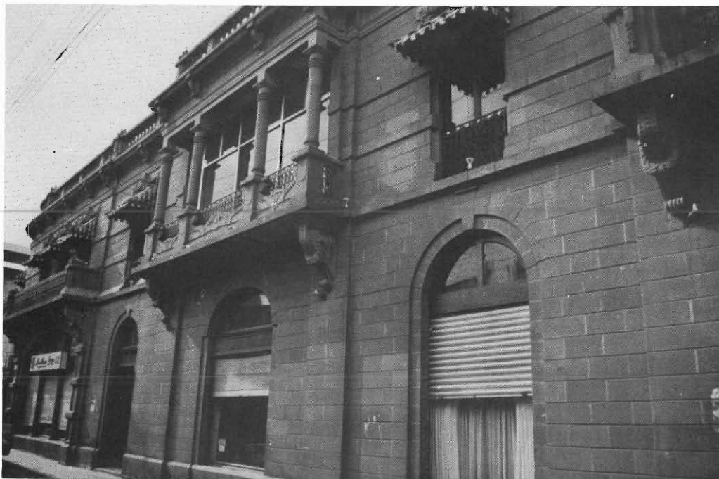
Fotografía. Fachada que da a la calle Guerrero, en la que sobresale la tribuna antes mencionada. Arq. Jesús Villar Rubio.
