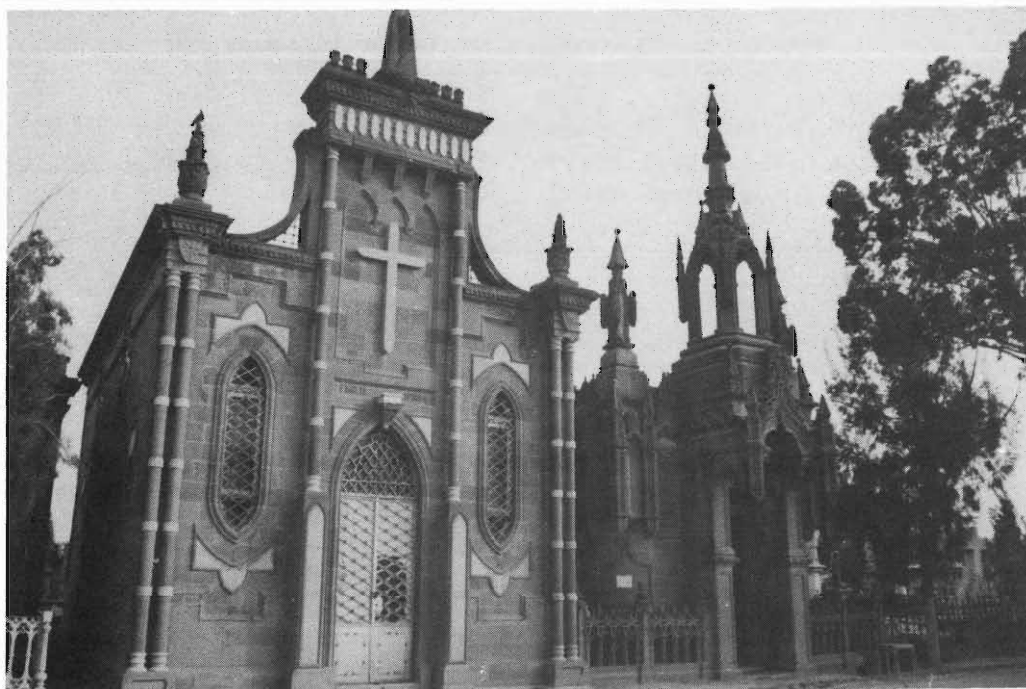
Fotografía. Estado actual de la capilla funeraria. Arq. Jesús Villar R.
