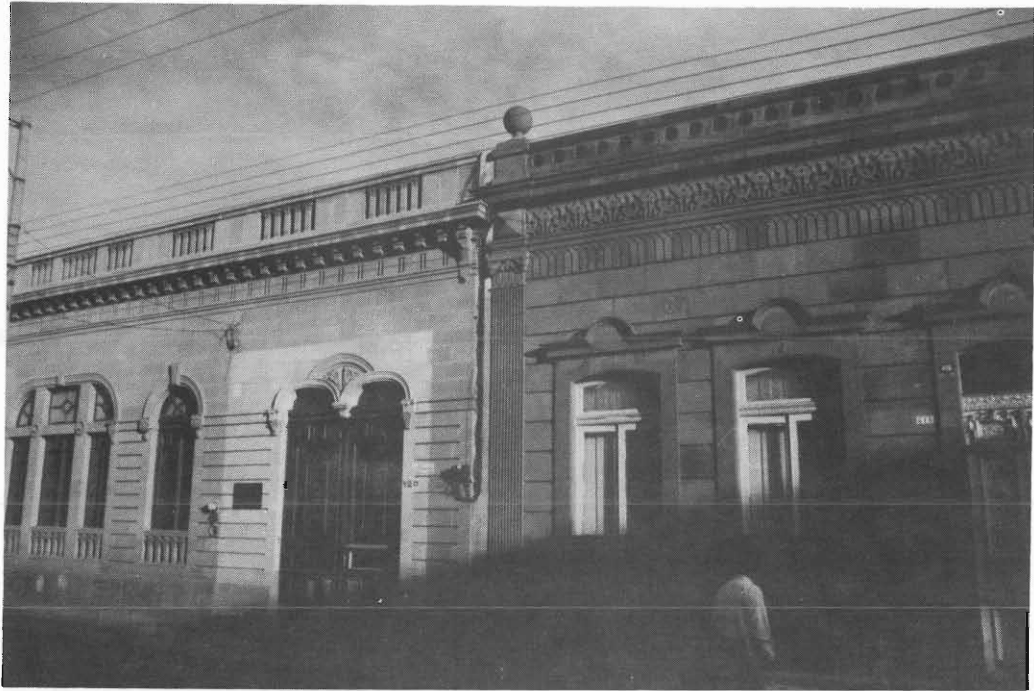
Fotografía. Fachada principal, casa del Sr. Joaquín Cabrera. Arq. Jesús Villar Rubio.
