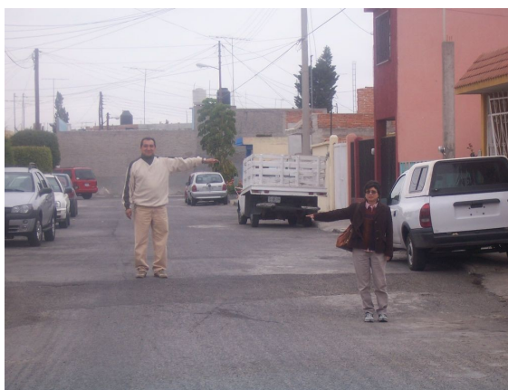
Figura 3-7: Desplazamiento vertical de una calle
