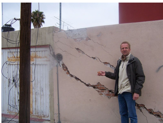
Figura 3-6: Ruptura en el muro de una casa
