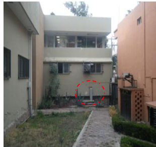
Fotografía 5. Tanque de gas LP en el Laboratorio de Beneficio de Materiales.
