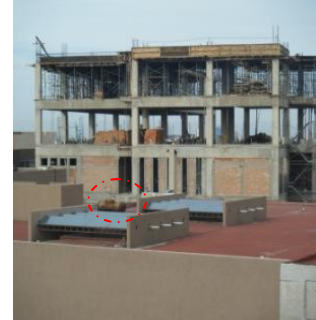
Fotografía 7. Tanque de gas LP en el Edificio C.C.I.M.
