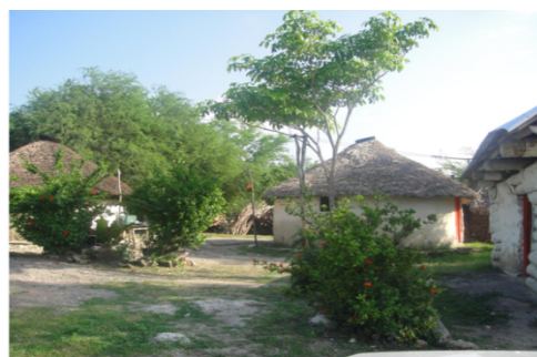
Viviendas de la zona rural de la cuenca del Río Valles, construida con materiales vegetales mezclados con barro.
