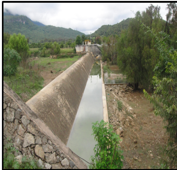
Desvió de aguas para la hidroeléctrica
