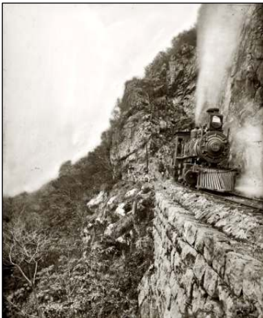
Figura 5.31: La vía del ferrocarril en el cañón, 1890
