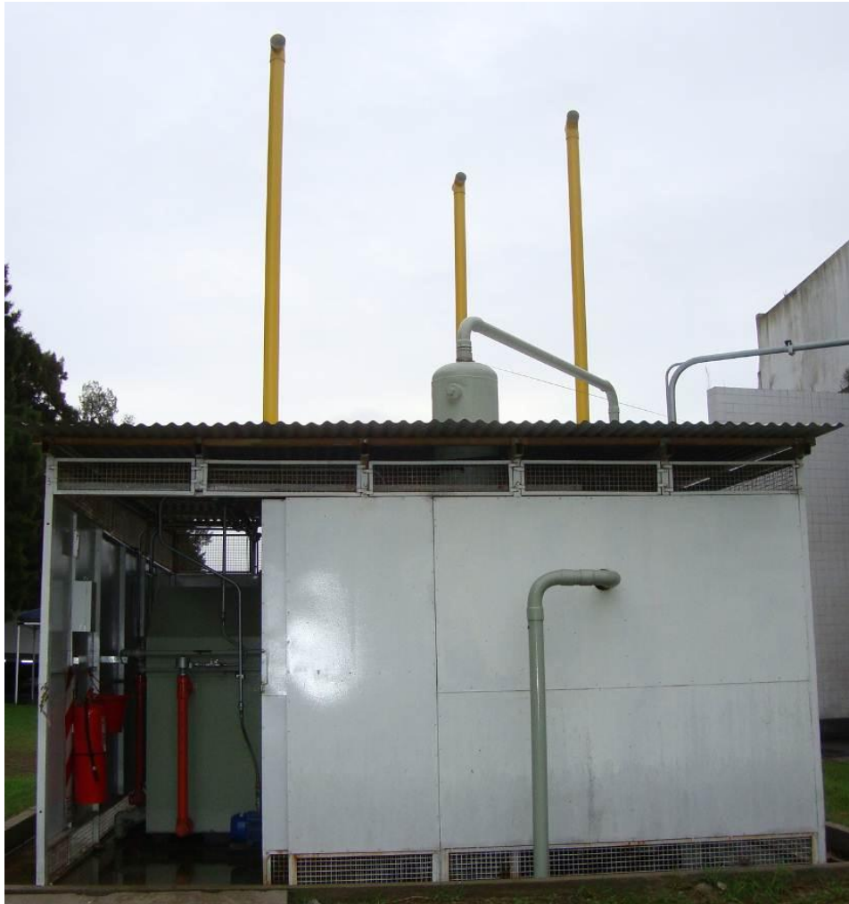
Figura 13: Recinto donde se alojan los equipos de remediación.
