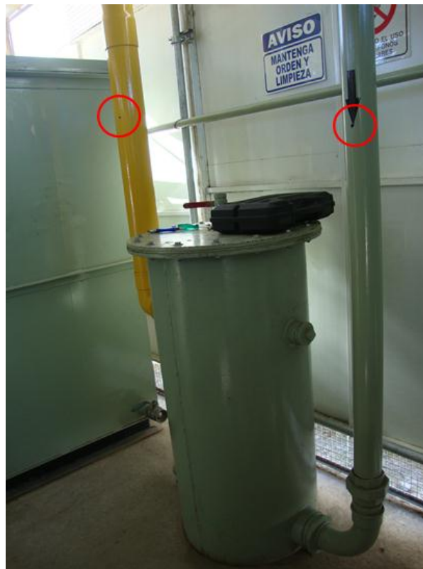
Figura 16: Port toma muestras, a la entrada y salida del filtro
