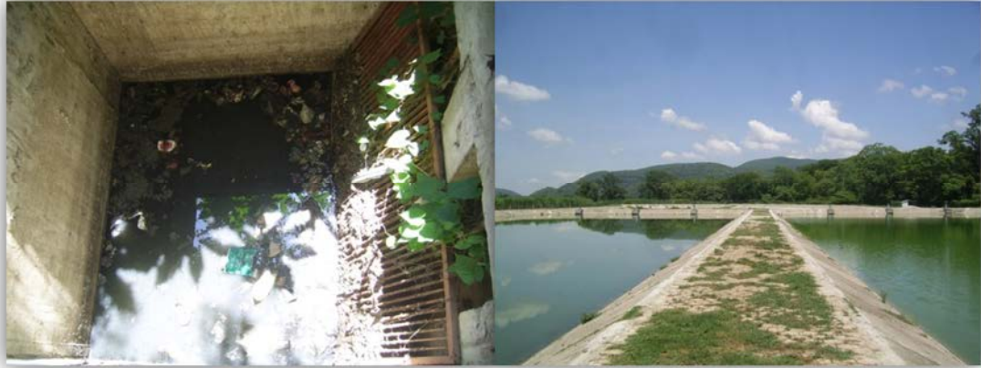
FOTO 7. PLANTA DE TRATAMIENTO DE AGUA RESIDUAL DE TAMASOPO
