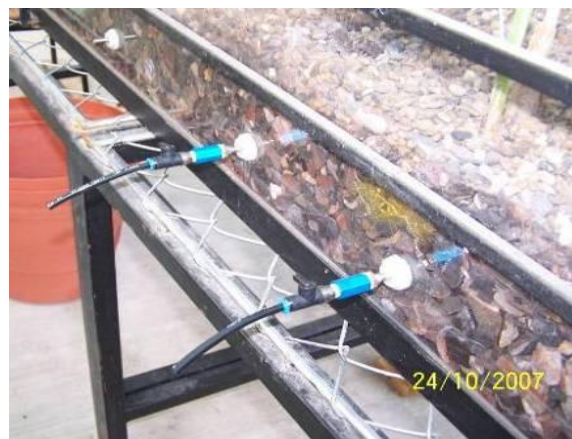
Figura 3.8. Aspecto de los puertos de muestreo instalados en el humedal.
