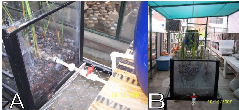
Figura 3.6. Tuberías para el afluente (A) y para el efluente (B).
