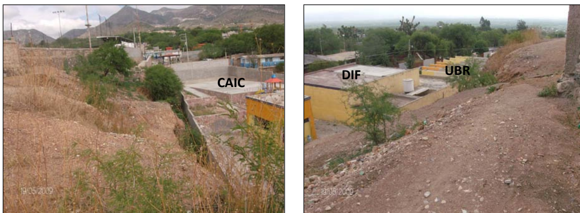
Figura 69. Instalaciones de la CAIC (Centro de Atención Infantil Comunitaria), del DIF municipal y de la UBR (Unidad Básica de Rehabilitación) adjunto al talud norte del Terrero “Campo de Beisbol” en Villa de la Paz.
