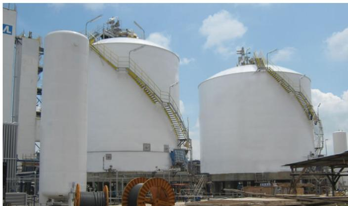
**Figura 1.2.-** Tanques de almacenamiento de líquidos criogénicos, diseño de doble pared.
