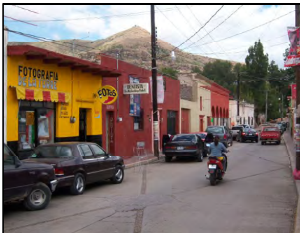
Se observa una serie de volados que son discordantes del lenguaje original del edificio
