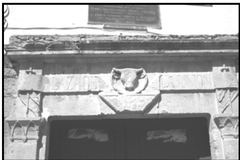
Fotografía tomada de dintel del acceso de plaza de toros La Unión, mostrando el año de su edificación. Tomada por el autor.
