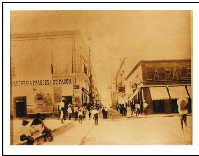
Integración de la calle Concepción a la Calzada de Guadalupe. (1900) Fotografías: Hinojosa Villareal Oscar
