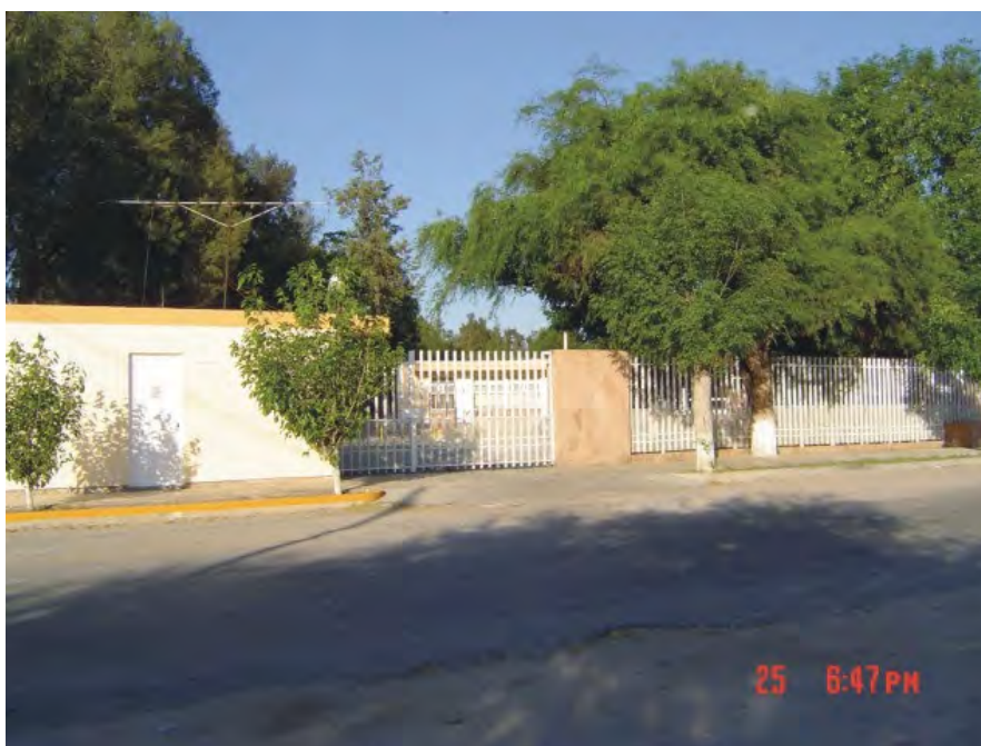
Fotografía 64. Fachada de la clínica Psiquiátrica Dr. Everardo Neumann Peña.
