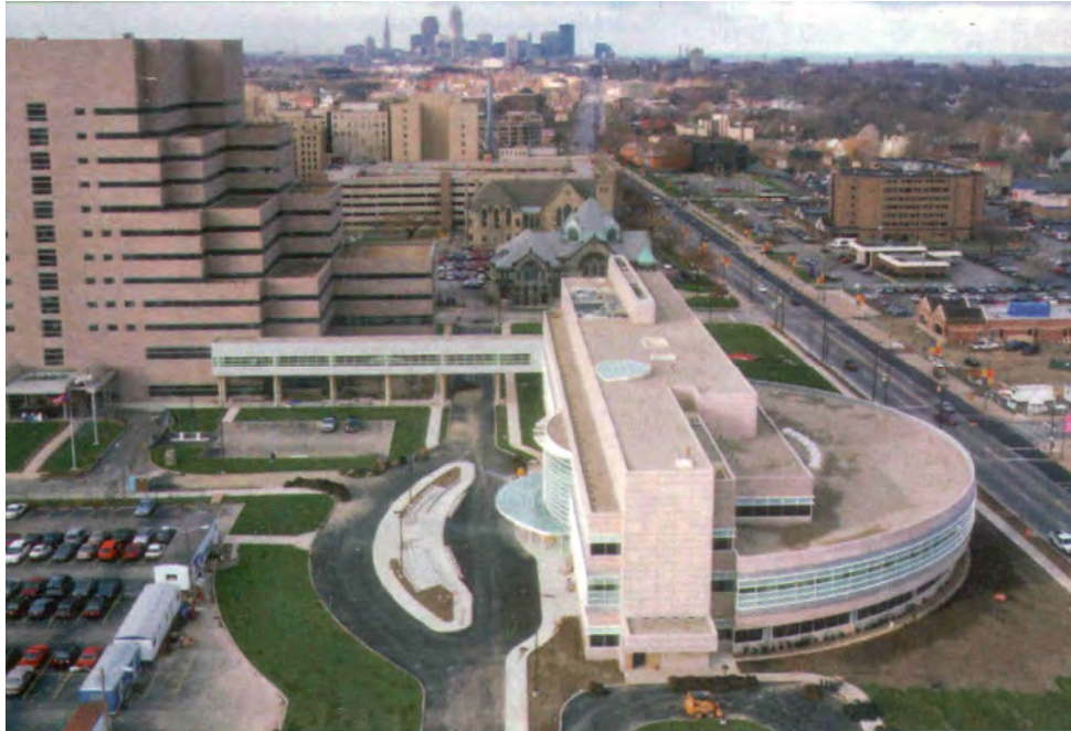
Fotografía 24. Vista aérea de la Clínica de Cleveland .
