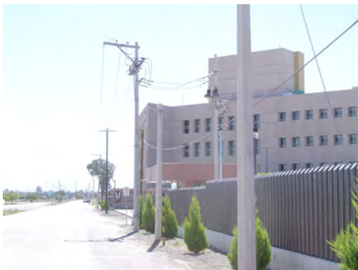
Fotografía 48. Infraestructura del lugar.
