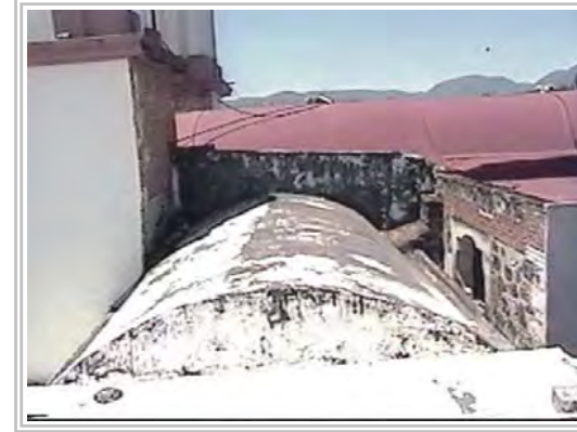
Vista exterior de la bóveda Archivo fotográfico del autor Fotografía 63
