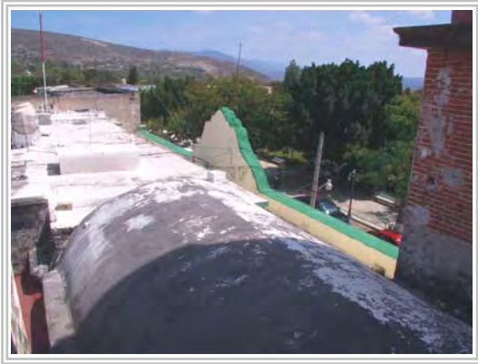
Vista exterior de la bóveda Archivo fotográfico del autor Fotografía 61
