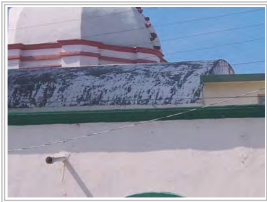
Vista exterior de la bóveda Archivo fotográfico del autor Fotografía 62
