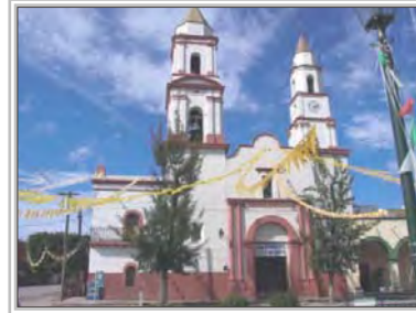
Templo de San Ciró Archivo fotográfico del autor Fotografía 34
