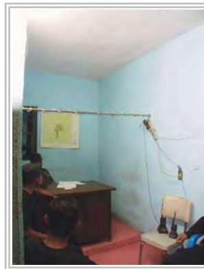
Oficinas de Seguridad Pública Archivo fotográfico del autor Fotografía 54
