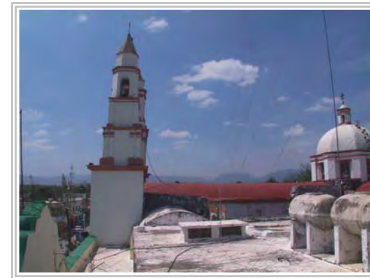
Vista exterior de la bóveda Archivo fotográfico del autor Fotografía 64
