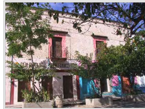
Primera casa habitación Archivo fotográfico del autor Fotografía 20
