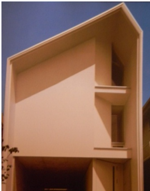
Imagen1 .Fachada de la vivienda
