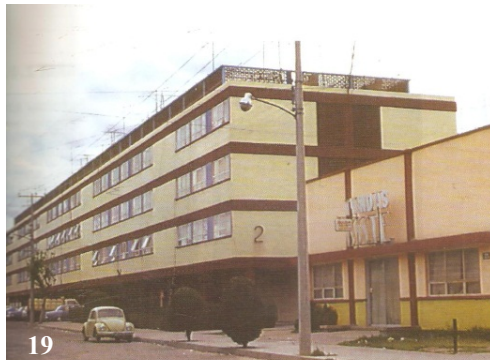
Imagen 17. Fachada del edificio Imagen 18. Fachada del edificio, Miguel Alemán Imagen 19. Perspectiva del edificio Mariano Jiménez. FOTO: Jesús Villar.
