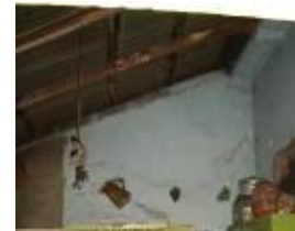
Foto 11. Cortés M. 2006. Cubierta de Lámina, soportada por vigería de madera.
