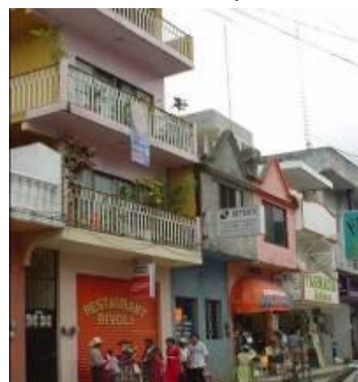
Foto 4. Cortes Mar, 2004. Cambio de uso de suelo habitacional por comercio, deterioro de la imagen urbana.
