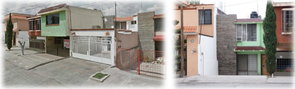
Ilustración 11. Casas construidas bajo el nivel de la banquetta en la avenida Mariano Jiménez colonia Balcones del Valle
