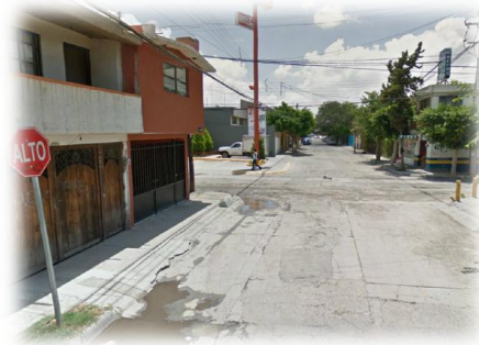
Ilustración 12. Esquina Fray José de Gauna con Margarita Castro donde hay acumulación de agua en la colonia Ricardo B. Anaya
