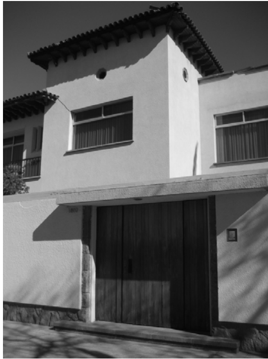
Remodelación de la vivienda neocolonial de la señorita Magdalena Ortega. Avenida Venustiano Carranza y Fray Diego de la Magdalena No. 570, de 1977-1983. Fachada, detalle de esquina y boceto preliminar. (Fotos: Martín Ernesto García Muñoz)
