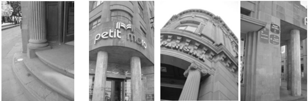
Detalles y acceso del Palacio Monumental de Henri Guindon y el Ing. Arnold Nillus. Detalles y acceso del edificio San Rafael. (Fotos: Martín Ernesto García Muñoz).
