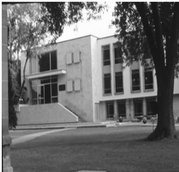
Vistas exterior e interior del anexo sur en la casa de la Cultura (Fotos: Martín Ernesto García Muñoz)
