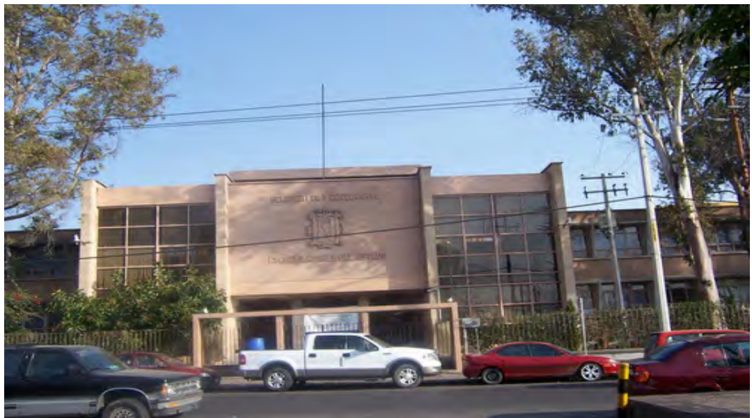
Fachada principal de la Escuela Normal del Estado. (Foto: Martín Ernesto García Muñoz)
