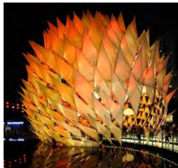
Imagen 105. Obra terminada desde el exterior. Propiedad de Golden moon. Press Pack. Publicado en 2012. Recuperada del enlace: http://l-e-a-d.pro/projects/golden-moon/2664 el día 19 de enero de 2013.
