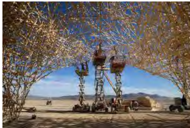
Imagen 113. Grúas durante la construcción. Publicada por transform creatives inspired by creatives el 16 de noviembre de 2007. Recuperada del enlace: http://transform-mag.com/ps/uchronia-%E2%80%93nevada-desert-usa#id=2354 .
