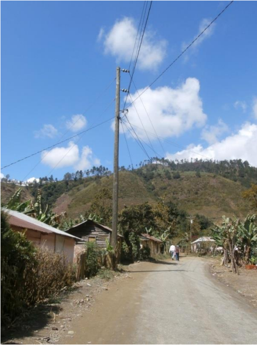
Photo 9. Grid (House connection) Paso de la Perra
