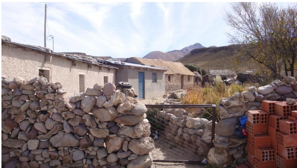
Foto 3. Infraestructura de las viviendas, comunidad de Sivingani, 2015.
