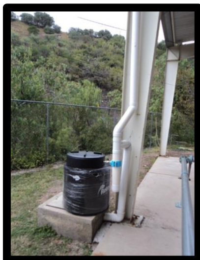
Figura 7. Sistema de captación del agua de lluvia instalado en el Laboratorio de Hidráulica de la Universidad de Guanajuato.
