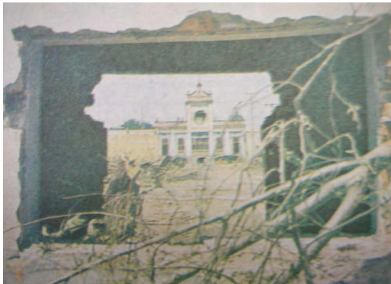
Figura 4. Vista desde el muro perimetral poco antes de su demolición, tomada del periódico Momento 6 de mayo 1994.
