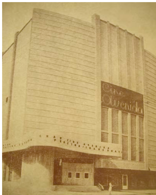
Figura 33. Fachada Cine Avenida, tomada de Revista inauguración, 10 de octubre 1947. Obtenido de Bibliografía Potosina.
