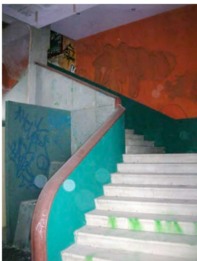
Figura 43. Aspecto actual escalera, foto: SSB, noviembre 2008
