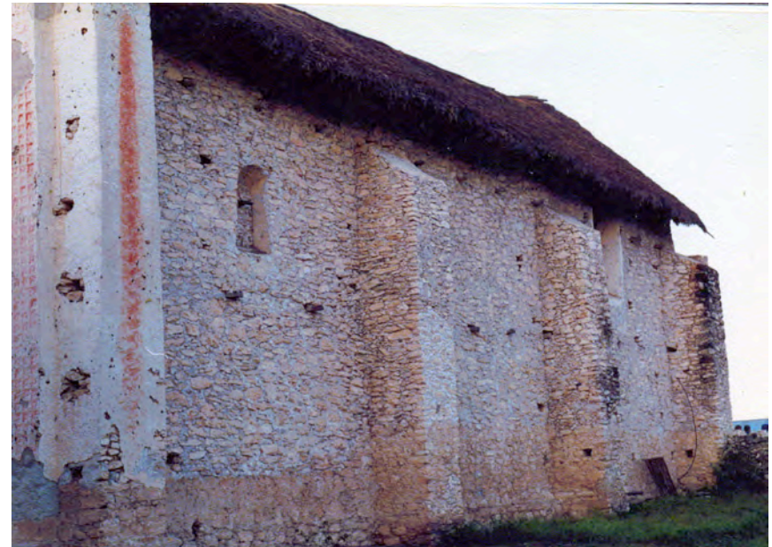
Ilustración 28 Fachada Sur. Chávez Chávez
