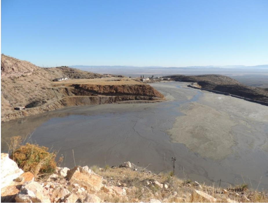
Imagen 1. Presa de jales antigua circunscrita por presa de jales nueva
