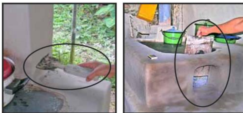
Figura 4. Reguladores para chimenea y entrada de leña. Fuente: Proyecto Gestión Integral de agua en la cuenca del río San Juan. ¡Construyamos la estufa ahorradora! 2007
